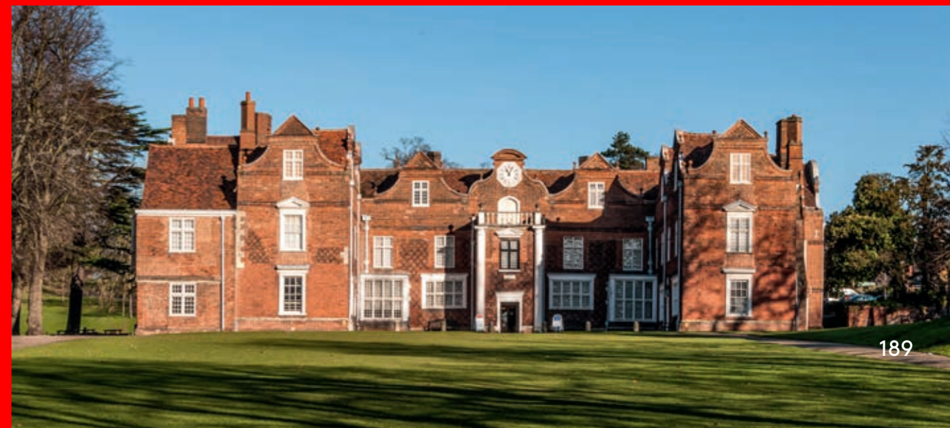
Exterior: Línea Massello Villa según diseño laqueado RAL 9016 Interior: Línea Massello Villa según diseño en Okumé 7 Sistema de 2 hojas centrales con laterales fijos y panel superior de arco como réplica del cerramiento original, recuperación de los vidrios artísticos originales con acoplamiento de vidrio blindado
